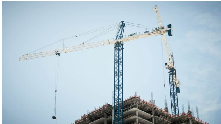
Tower Crane تاورکرین
